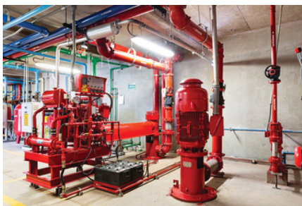
🔧 Bombas tipo turbina para servicio contra incendio # Modelo 10 GMC 📏 31.5 l.p.s (500 g.p.m)
