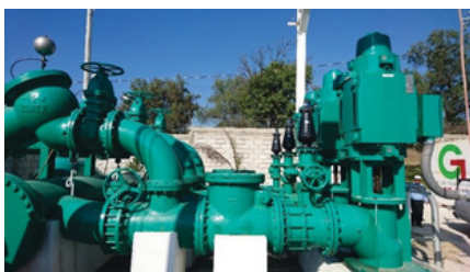
🔧 Bombas tipo flujo mixto # Modelo 16 PS 📏 400 l.p.s (6,340 g.p.m)
