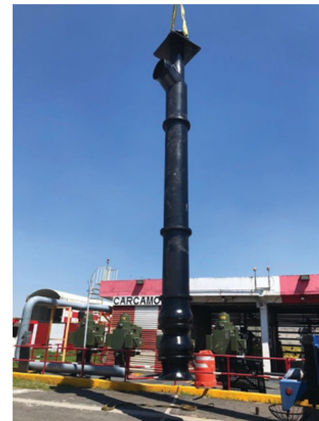
🔧 Bombas tipo flujo mixto # Modelo 24 LS 📏 1,000 l.p.s (15,850 g.p.m)
